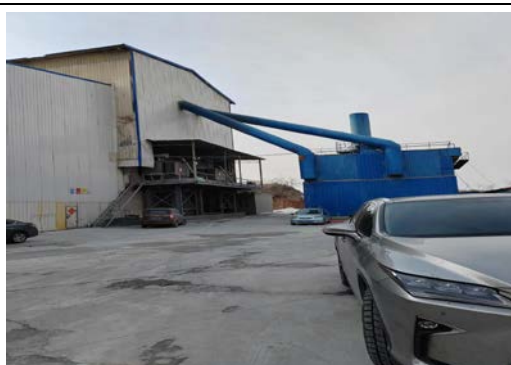
电弧炉除尘系统
